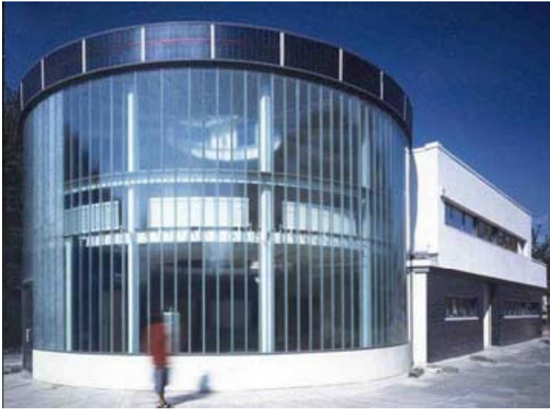
A-Si solar fascia Lambeth, UK
